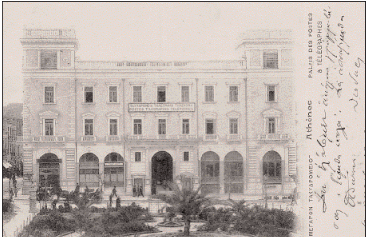
Το Μέγαρο Μελά στην πλατεία Κοτζιά σε καρτ-ποστάλ εποχής. Στέγαζε για τρεις δεκαετίες τις υπηρεσίες των Τ.Τ.Τ. Η εισαγωγή των τηλεφωνικών γραμμών γινόταν μεμονωμένα για κάθε συνδρομητή απευθείας από τα παράθυρα των τεσσάρων πυργίσκων του κτιρίου χωρίς τη χρήση προστατευτικών οργάνων, αλεξικεραυνών και ασφαλειών. Ετσι ήταν συχνές οι πυρκαγιές και οι βλάβες από την πτώση κεραυνών στο κτίριο.
